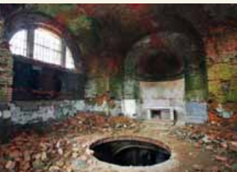
Interiér dříve zdobený Frindovou výmalbou
